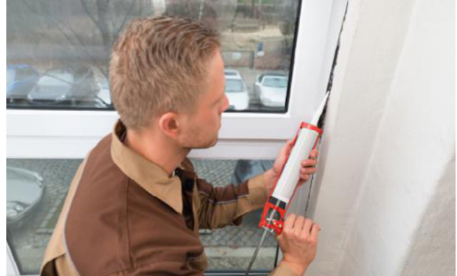
معالجة تسرب الهواء على مستوى التقاء أطر النوافذ مع الحائط
