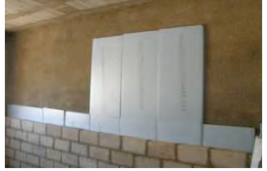
الشكل 7. عدم ترتيب المواد بشكل يسبب التلف والخسارة
