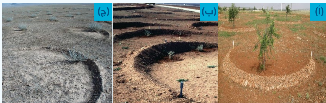
الشكل 4. سدات شبه دائرية لحصاد مياه الأمطار للأشجار (أ) في فلسطين وللشجيرات الرعوية؛ (ب) في الأردن؛ (ج) في الجمهورية العربية السورية
