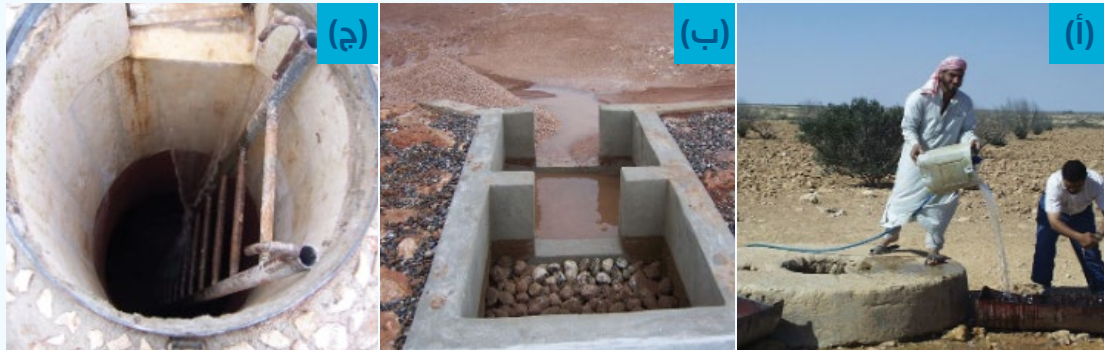
الشكل 13. (أ) الآبار الأرضية التقليدية في شمال مصر؛ (ب) بئر مجهزة بحوض ترسيب ومرشح بالحصى؛ (ج) بئر تم تجديدها في الجمهورية العربية السورية
